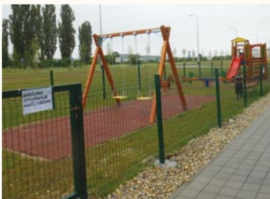
Paneli su izrađeni od pocinčane žičane mreže promjera 5mm koja je zavarena, te plastificirana. Stup je izrađen iz čeličnih cijevi kvadratnog presjeka 60x60 s plastičnom kapom na gornjoj strani, te ugrađenim maticama za pričvršćivanje ogradnog panela. Standardna boja panela je zelena RAL 6005.
