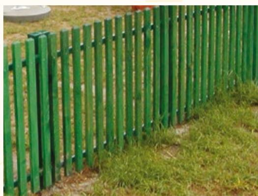
Ograda je izrađena od kvalitetne drvene građe, stupovi 120x120x800 mm, horizontalni nosači, letvice, 2 kom 80x40 mm i letvice dimenzija 20x60 mm. Montaža se vrši sa čeličnim pocinčanim anker nosačima. Vrata jednokrilna-zaokretna na jednoj strani. Sve zaštićeno temeljnom bojom i lakom.
